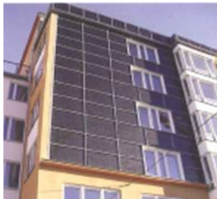
Bild 4: Solceller integrerade i fasad.
