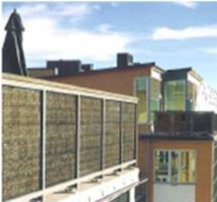
Bild 1: Solceller på balkongräcke.
