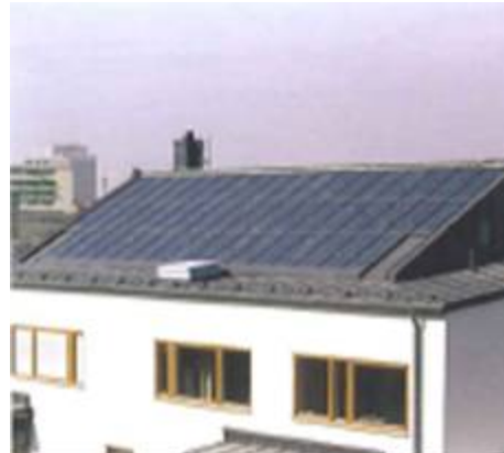
Bild 2: Solceller integrerade på tak.
