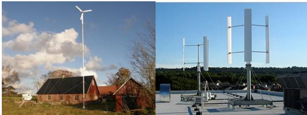
Figur 7: T.v. ett VAWT-vindkraftverk, t.h. ett litet HAWT-vindkraftverk (2,2 kW) för försörjning av en villa.
